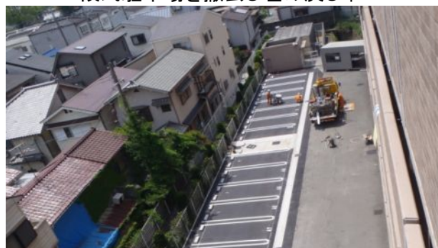
平面駐車場の舗装中
