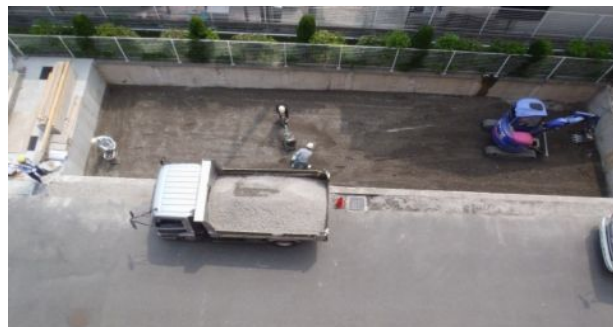
2段式駐車場を撤去し埋め戻し中
