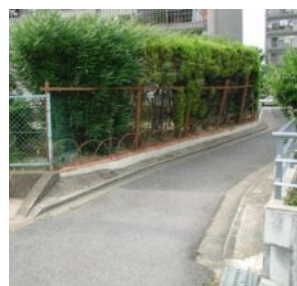
歩道入口 工事前
