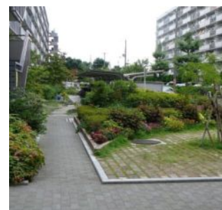
リニューアル工事後
