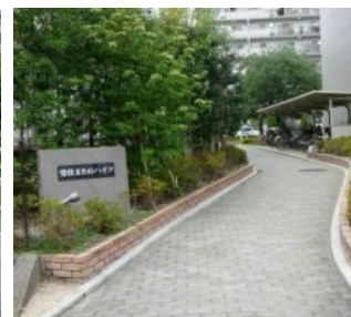
リニューアル工事後
