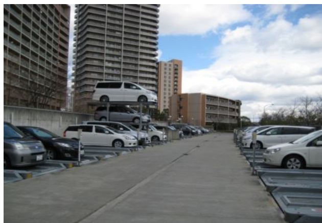
リバティパーク枚方の機械式駐車場(地下3段式)
